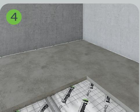
Поверх звукоизоляционного материала выполняется цементно-песчаная или бетонная стяжка толщиной минимум 60 мм. Стяжка должна быть армирована сеткой в 1/3 ближе к низу слоя.
