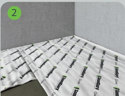
Поверх минеральных плит раскатывается материал SoundGuard Cover с нахлестом друг на друга примерно на 10 – 15 см, а также на стены на толщину стяжки.
